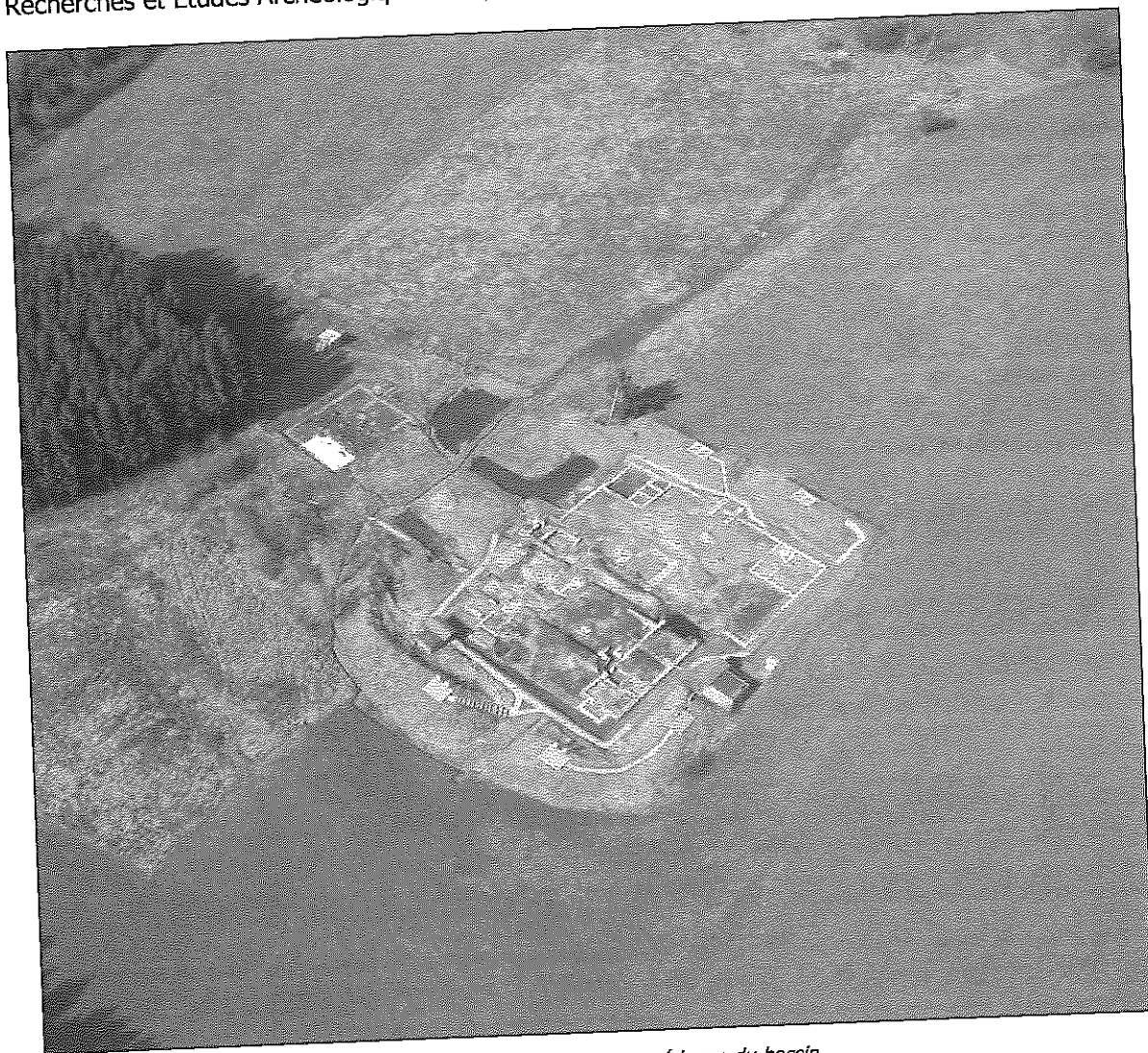
Fig. 1 : Villa de Mageroy, vue aérienne du bassin.
